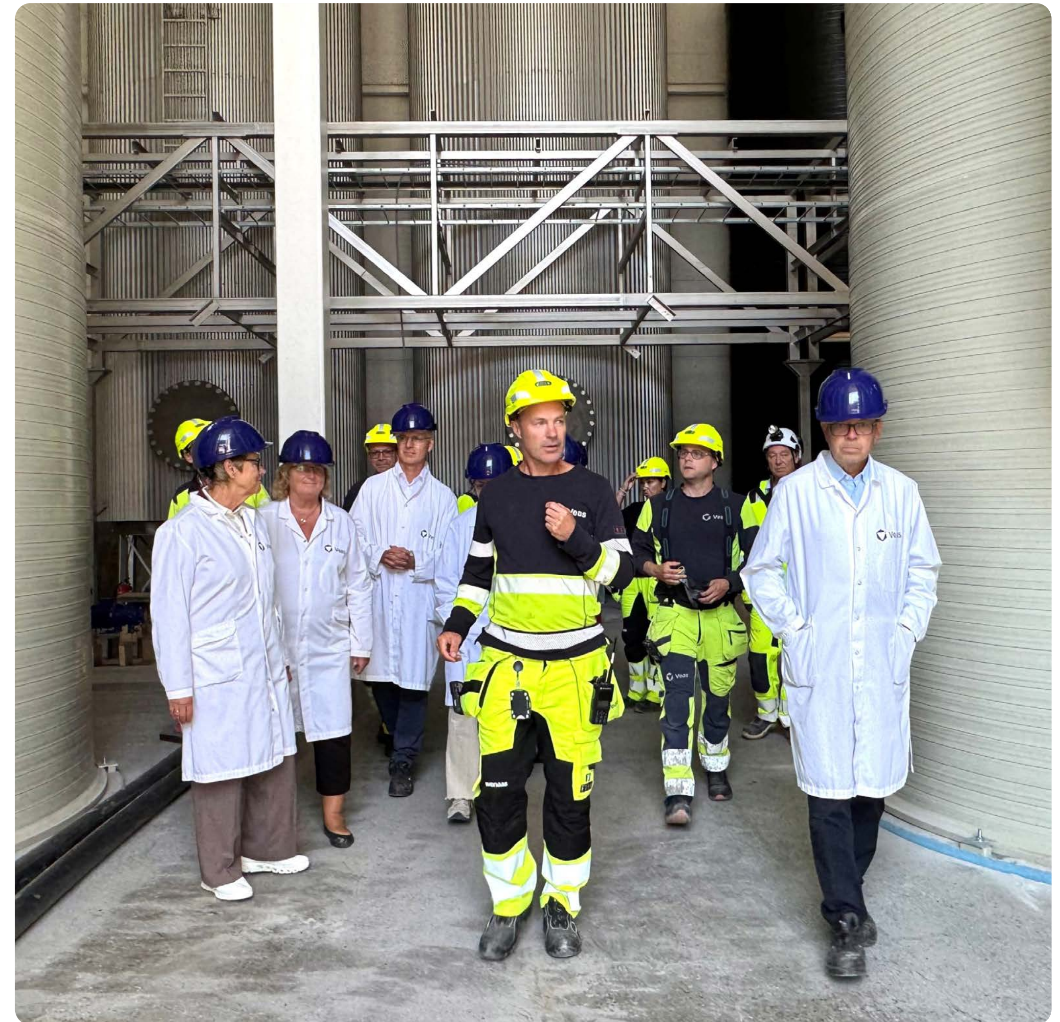
I prosessbygget i næringsparken er utstyr i ferd med å bli montert og testet. I august var konsernstyret på befaring.
