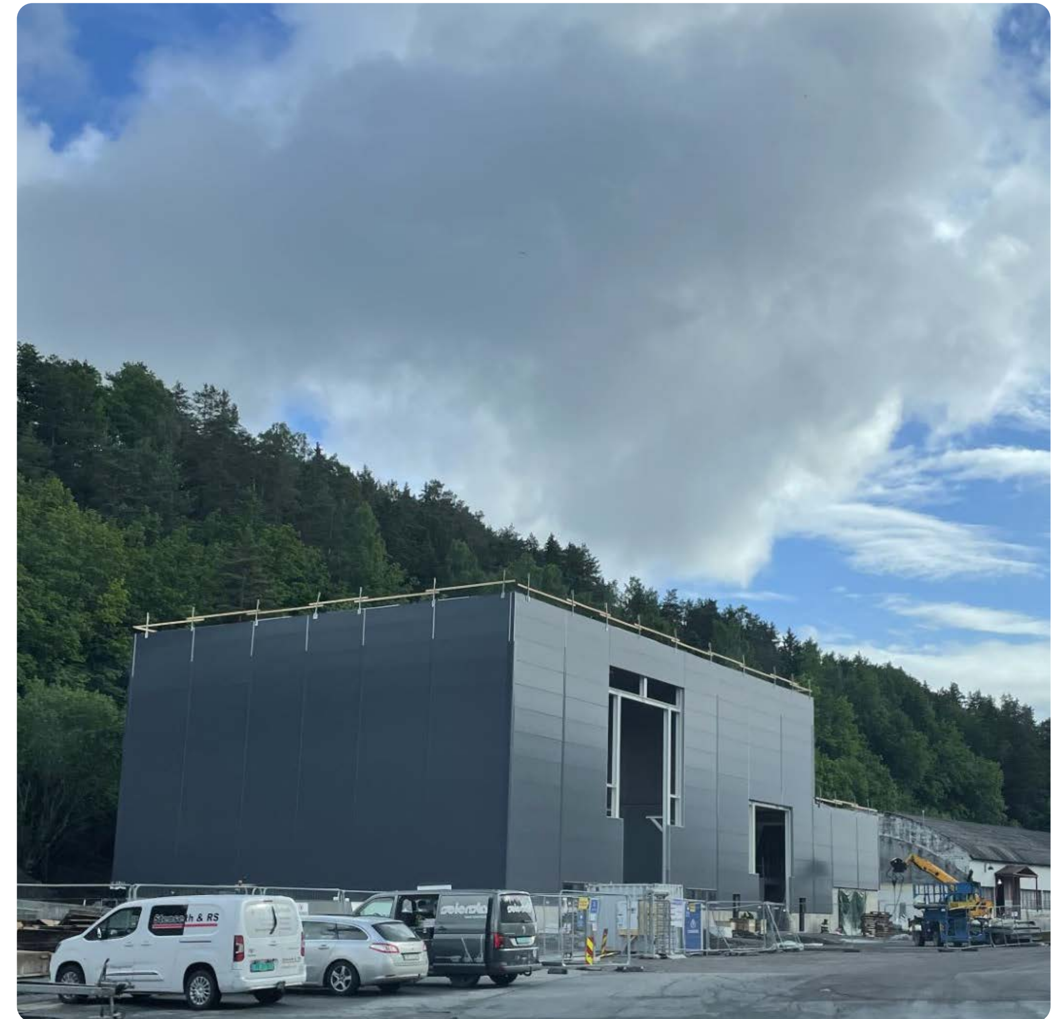
Prosessbygget i næringsparken nærmer seg ferdigstillelse.
