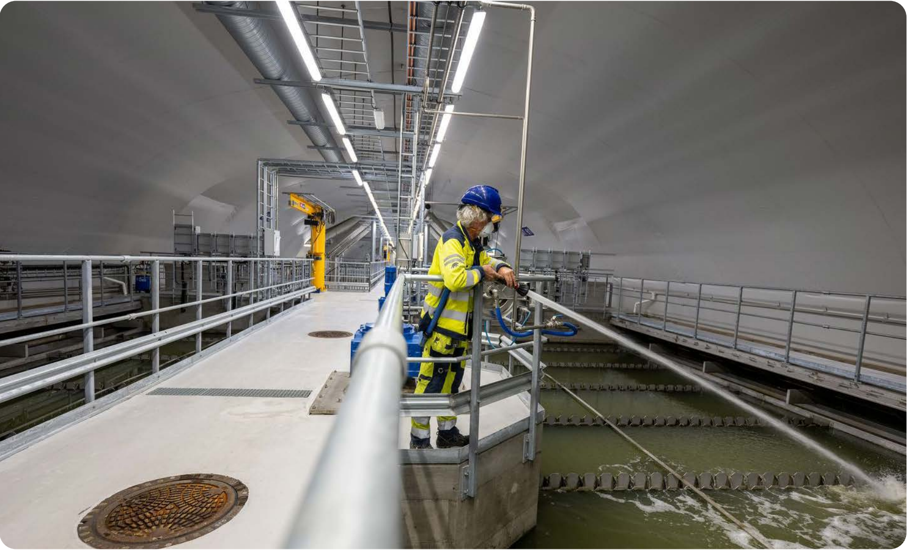
Prosesshallene 5 og 6 sto klar sommeren 2022, og Veas har nå nitrogenfjerning i åtte prosesshaller og har derved økt anleggets totale nitrogenfjerningskapasitet.
