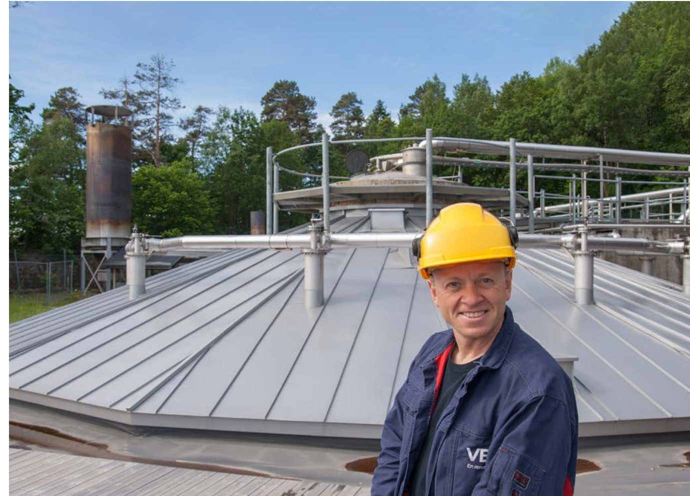
Det nye flytendegjøringsanlegget vil stå klart våren 2020, forteller prosjektleder Lars Wikborg Stokke. Biogass fra rånetankene ledes som før til gassklokken som er en buffertank. Herfra skal det bygges et gassrør – opp langs bioreaktorene, og deretter ned langs skråningen i naturreservatet – som leder biogassen til det nye anlegget der den blir omdannet til flytende biogass.
