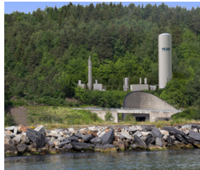
Det nye flytendegjøringsanlegget vil stå klart i andre kvartal neste år, forteller prosjektleder Lars Wikborg Stokke. Biogass fra råtnetankene ledes som før til gassklokken som er en buffertank. Herfra skal det bygges et gassrør – opp langs bioreaktorene, og deretter ned langs skråningen i naturreservatet – som leder biogassen til det nye anlegget der den blir omdannet til flytende biogass.
