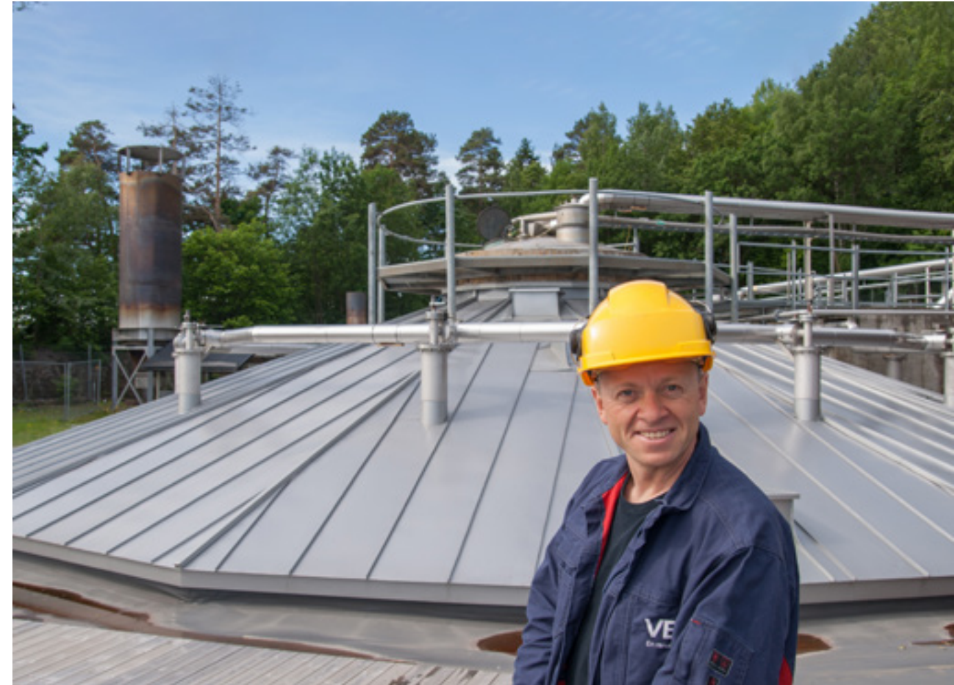
Det nye flytendegjøringsanlegget vil stå klart i andre kvartal neste år, forteller prosjektleder Lars Wikborg Stokke. Biogass fra råtnetankene ledes som før til gassklokken som er en buffertank. Herfra skal det bygges et gassrør – opp langs bioreaktorene, og deretter ned langs skråningen i naturreservatet – som leder biogassen til det nye anlegget der den blir omdannet til flytende biogass.
